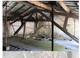
Après un nettoyage en profondeur, nous avons dû procéder au remplacement complet de la ferme. La trappe par laquelle passaient les sacs de blés est matérialisée par la mezzanine.
