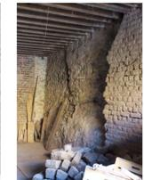
2 démolition des murs intérieurs qui semblaient anachroniques (briques) et décapage de l'enduit sur le mur original.
